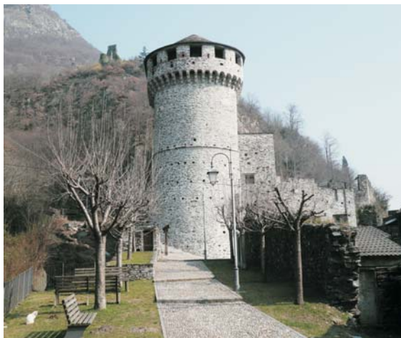
Il possente mastio del castello visconteo di Vogogna; alle spalle i ruderi della rocca.
